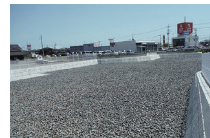
箱森地内 館野川調節池（令和3年完成）
