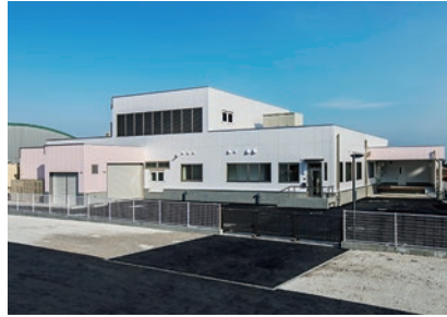
写真は吹上小学校給食共同調理場（令和3年完成）
