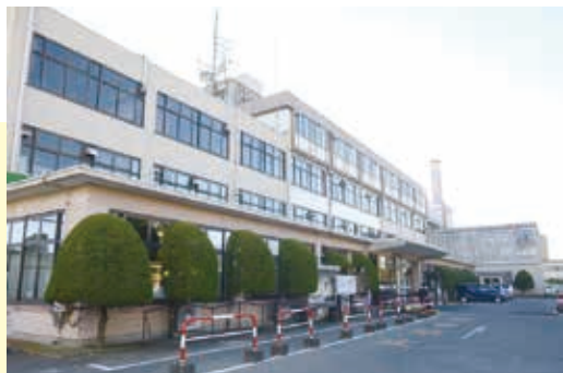
▲旧庁舎 旧庁舎は、昭和35年に建てられ、54年間市庁舎として利用してきました。
