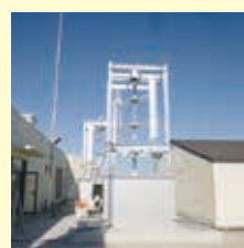
▼太陽光発電システム 議場の屋根の上に、20キロワットの同システムを設置しました。 ▲風力発電システム 発電量は6キロワットで太陽光発電システムと併せて、災害時等の電力を補完します。
