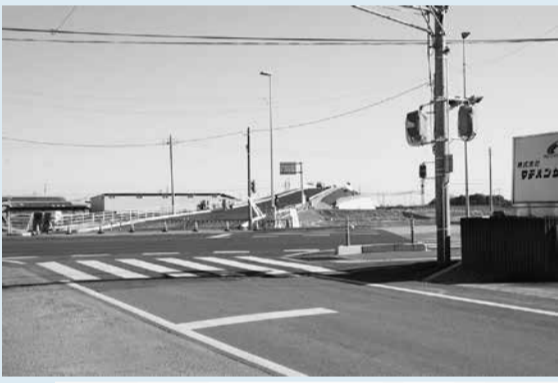
開通する市道 0 - 157 号線 川連側(写真①)、土与側(写真②)
