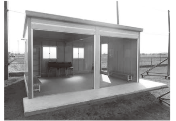
大宮運動広場に新設された休憩所
