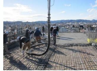
最上階となる3階の天井部分に配筋が施工され、コンクリートが打設されました。隅々までいきわたるように丁寧な作業で進められました。
