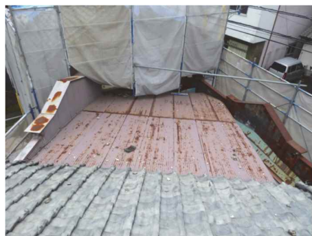
洋風店舗 屋根修理前
