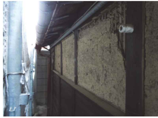
押縁下見板が取り付けられていた釘跡と、柱に水切りのシャクリがなかったことが確認できる様子
