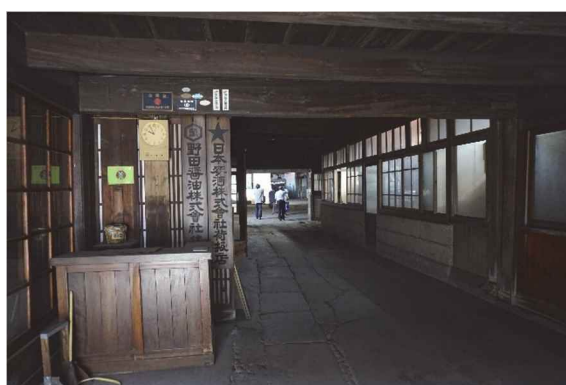
修理前（通り土間）
