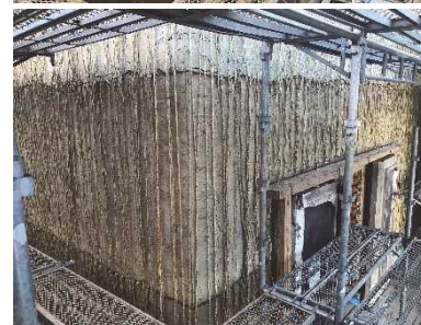
写真 3.2 土蔵の施工状況
