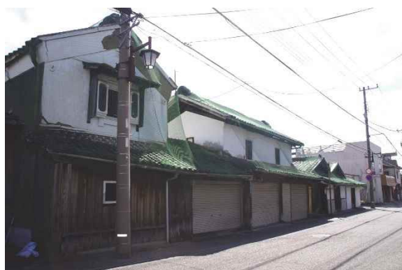
修理前（袖蔵と町並み）
