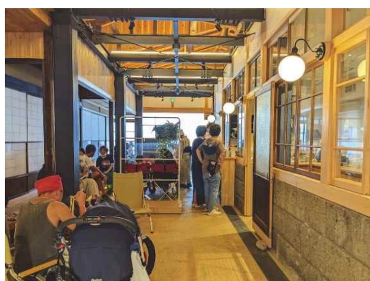
修理後（通り土間）
