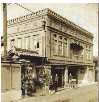
館野家竣工時（昭和 8 年(1933)）
