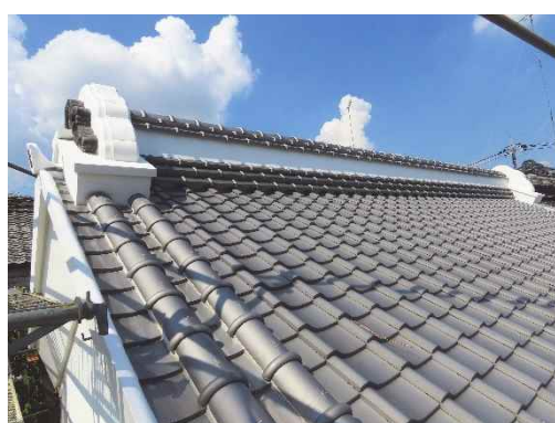
修理後の屋根
