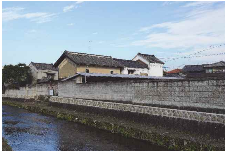
写真 1.15 巴波川から見る平柳河岸と大貫邸
