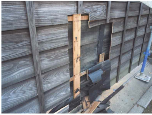
既存下見板の下地より旧状の押縁下見板が確認できる様子
