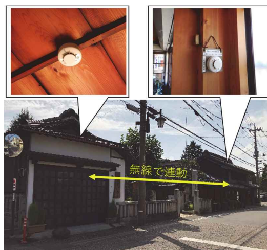
写真 2.13 無線連動型住宅用火災警報器設置状況
