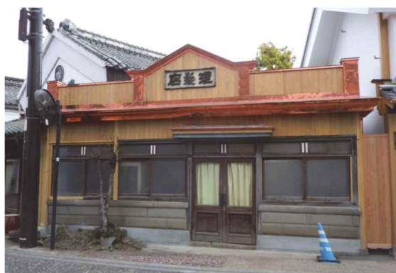
洋風店舗 修理後
