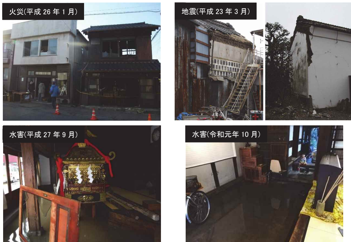
写真 2.7 嘉右衛門町伝建地区における近年の災害被害
