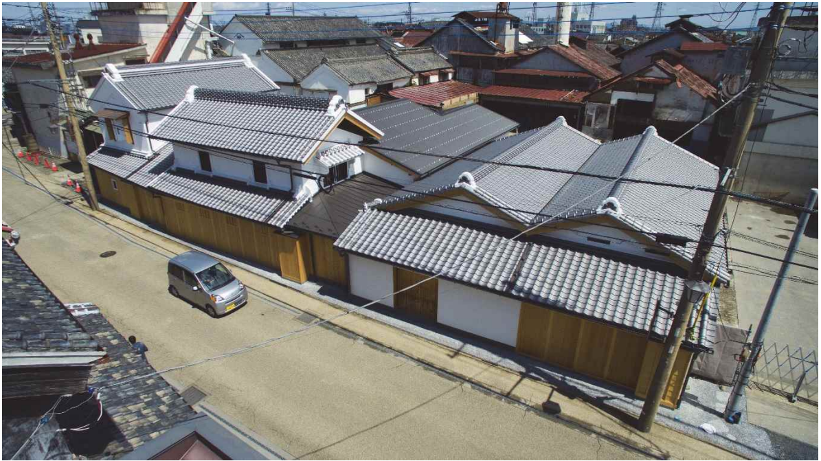
写真 2.5 第 1 期工事における伝統的建造物の修理工事後の様子（令和 2 年 4 月）
