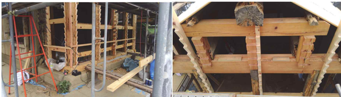
既存柱の側面につたかけ加工した補強添木を取付け
