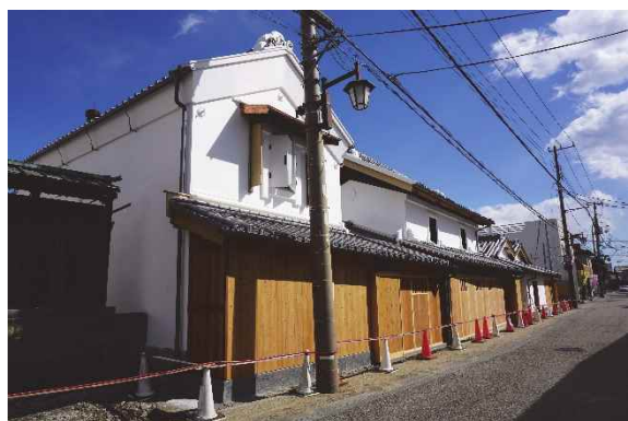
修理後（袖蔵と町並み）
