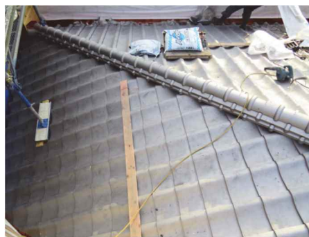
洋風店舗 屋根復元後
