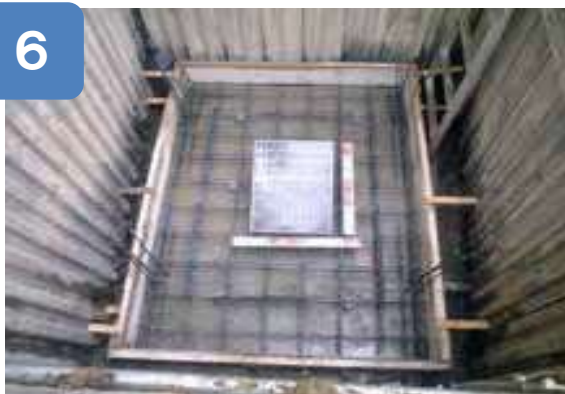
写真6 【ベースコンクリートの配筋状況】
