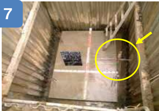
写真8 【ベースコンクリートの寸法確認】
