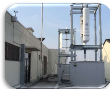
[栃木市役所本庁舎屋上]
