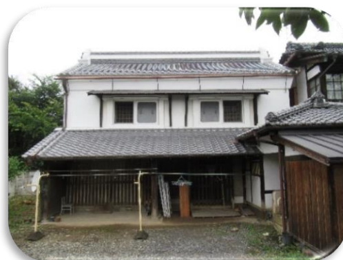
[修理済の建造物]
