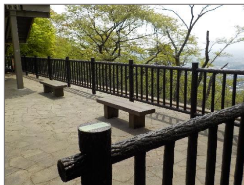
〔太平山県立自然公園内謙信平園地展望台の柵を改修〕
