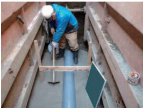
下水道管を地下に埋設する工事 (管は結構細い)
