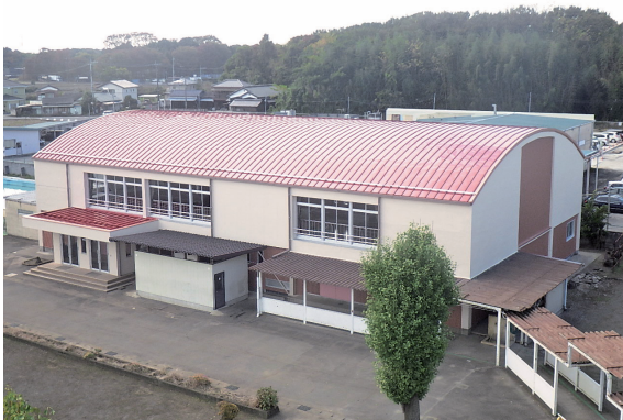
長寿命化改修工事を行った屋内運動場
