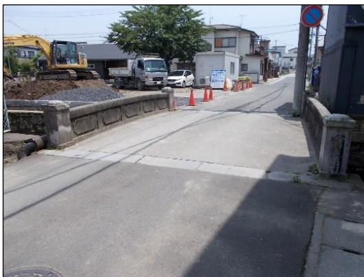
写真 ⑦寶橋 (昭和7年(1932))
