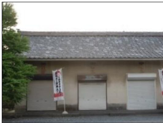
写真 神明宮境内の山車収納庫
