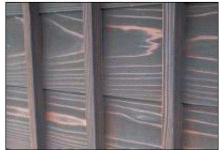
写真 簾子下見板張り
