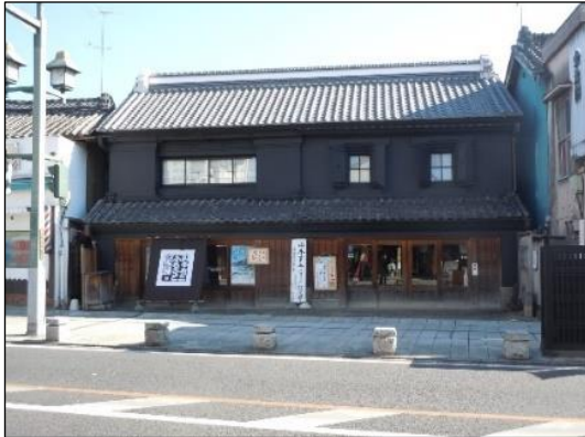
写真 a)-7 やまもとゆうどう 山本有三ふるさと 記念館南棟、北棟 [江戸末期建築《建築様式》] 国登録文化財
