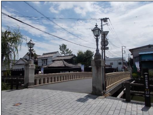
写真 ③巴波川橋 (昭和9年(1934))
