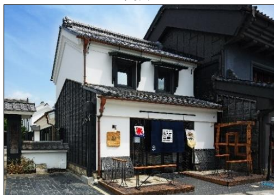
写真 a)-3 日光珈琲蔵ノ街 【綿忠はきもの店店舗】 [安政3年(1856)建築《墨書》] 国登録文化財
