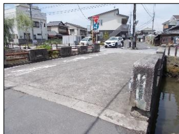
写真 ㉑新開橋 (昭和33年(1958))
