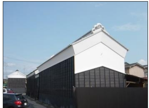
写真 本澤商店土蔵（西側）
