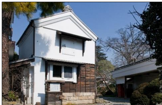
写真 b)-4 岡田記念館土蔵 [天保12年(1841)建築《墨書》] 伝統的建造物
