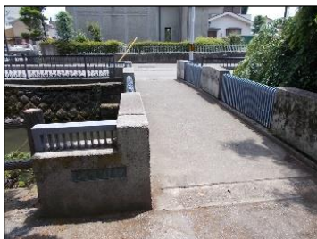
写真 ⑳栃木橋 (昭和44年(1969))
