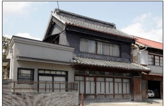
写真 a)-6 たなか 田中家見世蔵 [大正期以前建築《建築様式》] 伝統的建造物
