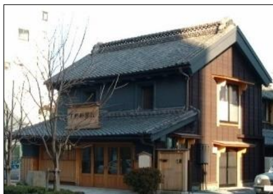
写真 a)-4 下野新聞社栃木支局 【旧毛塚肥料店見世蔵】 [文久元年(1861)建築《墨書》] 国登録文化財
