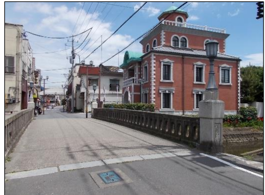
写真 ④相生橋 (昭和7年(1932))
