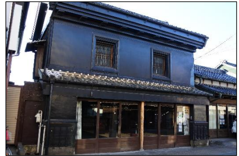
写真 大貫家(旧大貫定衛商店)
