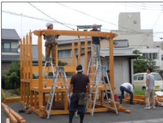
写真 仮殿の設営
