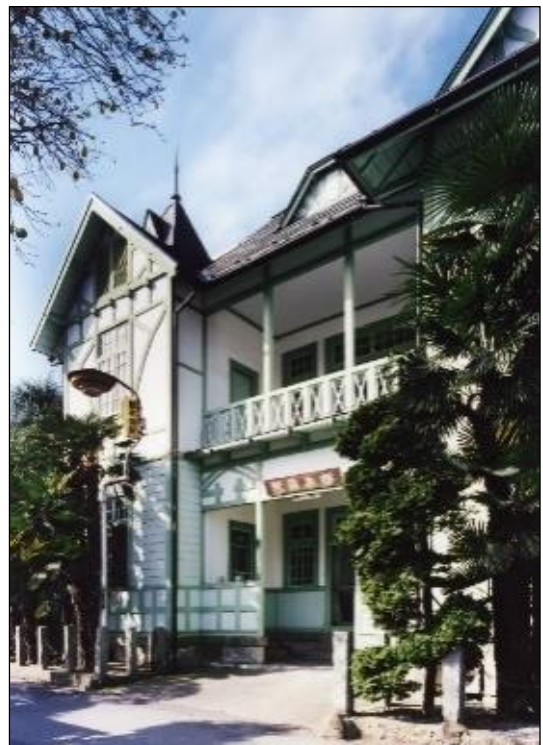
写真 c)-4 医療法人杏林会 栃木中央クリニック 【旧栃木病院】 [大正2年(1913)建築《建築様式》] 市指定
