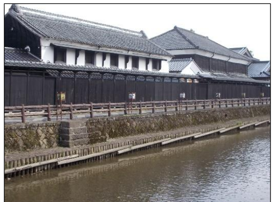
写真 巴波川の石段と根継工
