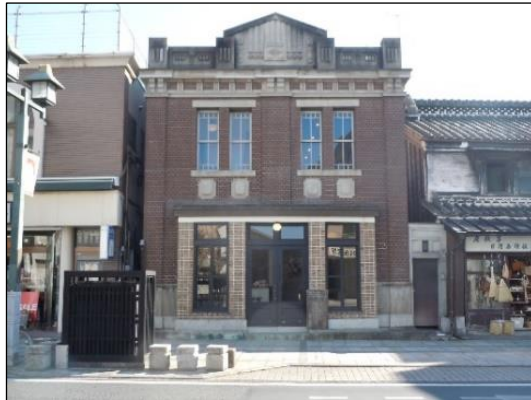
写真 c)-1 パーラートチギ 【関根家住宅店舗】 [大正11年(1922)建築《建築様式》] 国登録文化財
