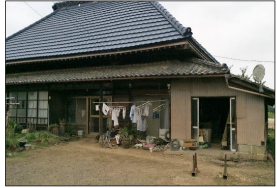
写真 慶応元年(1865)建築の主屋に昭和20年代に増築して造った作業場 (主屋の右側)
