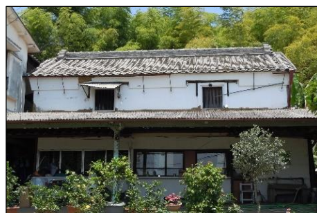
写真 下屋の下が作業場兼販売所の 大正6年(1917)建築の蔵
