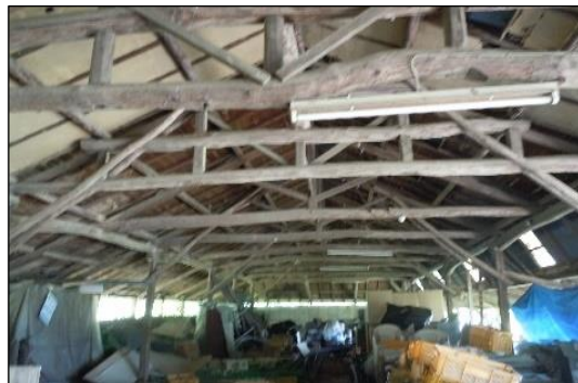
写真 にわとり小屋だった作業場の 土葺き屋根の下地
