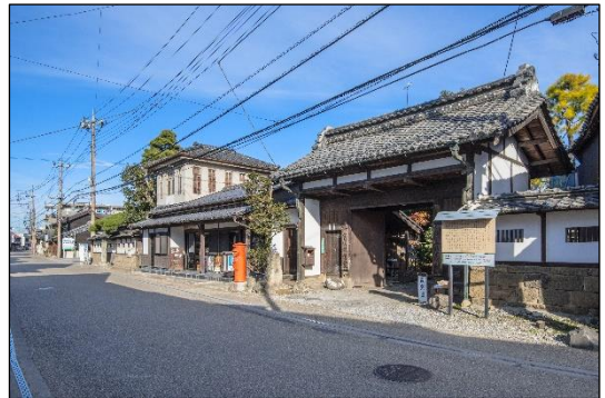
写真 嘉右衛門町伝建地区内の電線・電柱
