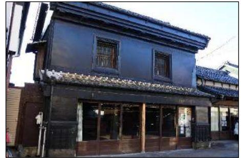
写真 大貫家(旧大貫定衛商店)
