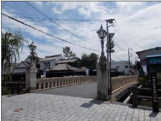
写真 ③巴波川橋 (昭和9年(1934))
