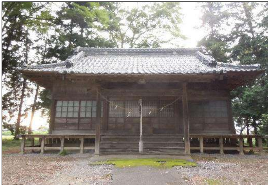
写真 造営された拝殿
