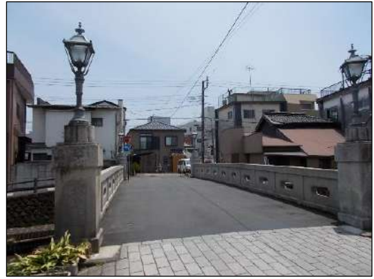
写真 ②倭橋 (昭和5年(1930))
