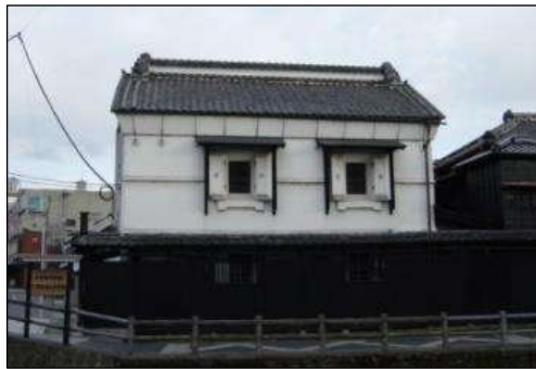
写真 b)-7 塚田家住宅文庫蔵 [明治32年(1899)建築《墨書》] 国登録文化財・景観重要建造物
