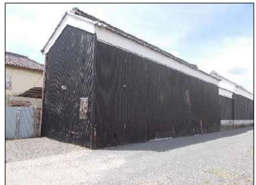
写真 本澤商店土蔵（東側）
