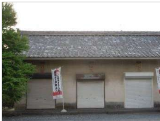
写真 神明宮境内の山車収納庫
