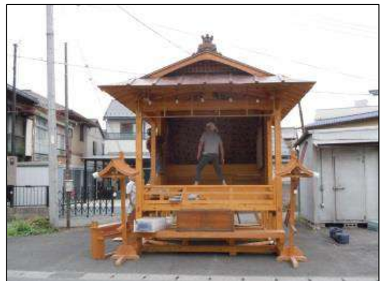
写真 設営された仮殿
