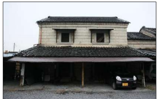
写真 b)-5 のじり 野尻家石蔵 [大正15年(1926)建築《墨書》] 伝統的建造物
