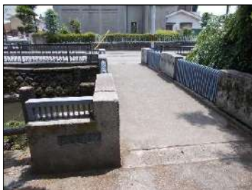
写真 ⑳栃木橋 (昭和44年(1969))
