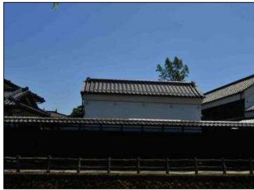
写真 b)-11 塚田家住宅旧米蔵 こめぐら [大正13年(1924)建築《建築様式》] 国登録文化財・景観重要建造物
