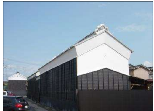
写真 本澤商店土蔵（西側）
