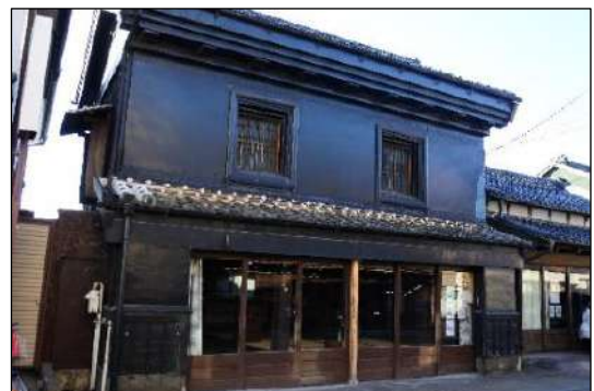
写真 a)-2 おおぬき 大貫家見世蔵 [天保5年(1834)建築《墨書》] 伝統的建造物
