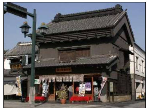
写真 とちぎ蔵の街観光館（旧田村家）
