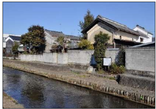
写真 巴波川沿いの土蔵群
