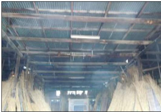
写真 昭和39年(1964)から使用し、 昭和55年(1980)に木の電柱の 廃材を使って改修された倉庫の内部
