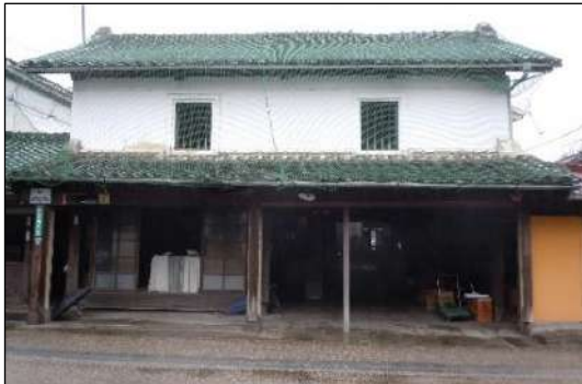
写真 a)-5 旧ヤマサ味噌見世蔵 (置き屋根形式) [江戸末期建築《建築様式》] 伝統的建造物
