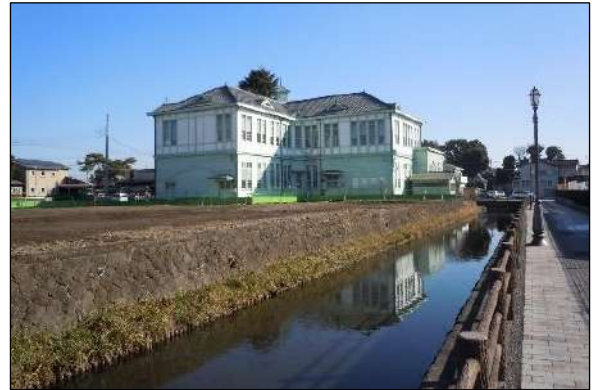
写真 ① 県庁堀川と旧栃木町役場庁舎
