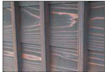
写真 簾子下見板張り
