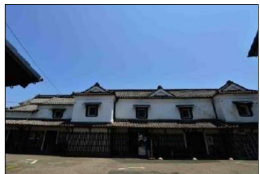
写真 b)-10 塚田歴史伝説館 事務室・売店及び休憩所 [大正5年(1916)建築《墨書》] 国登録文化財・景観重要建造物
