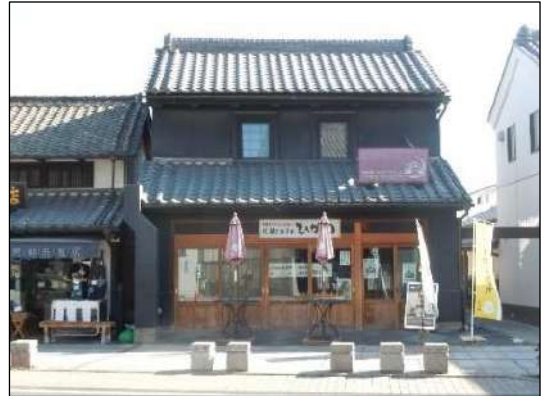
写真 a)-8 北蔵カフェひがの 【 きたう 佐藤家住宅店舗】 [明治中期建築《建築様式》] 国登録文化財
