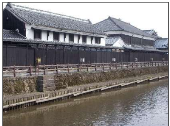
写真 巴波川の石段と根継工
