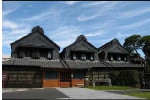
写真 b)-5 善野家土蔵(通称おたすけ蔵) [東蔵 文化年間(1804~1818)初期建築、 中蔵 天保2年(1831)以前建築、 西蔵 天保11年(1840)建築《墨書》] 市指定
