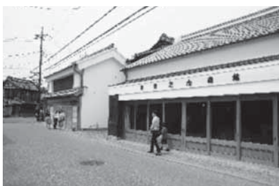
修理が進む保存地区（伝建保存事業）
