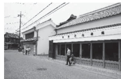
修理が進む保存地区（伝建保存事業）
