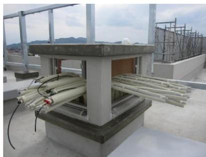
3階屋上は、機械設備を設置する台座が完成しました。周囲には目隠しとなるフェンスを取り付けるため、強靱な鉄骨が施工されています。また、配管類等を保護するための構造物:通称「ハト小屋」には、エアコンの配管が数多く見えます。
