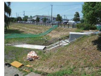
旧赤津川放水路 (令和5年5月時点)
