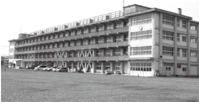
再整備される旧栃木中央小
