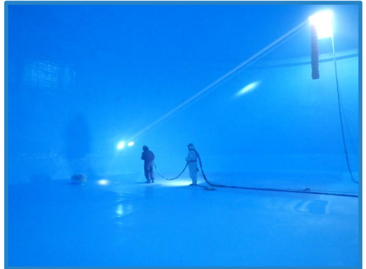
おおつかじょうすいじょう はいすいち ないぶ 大塚浄水場 配水池(内部)
