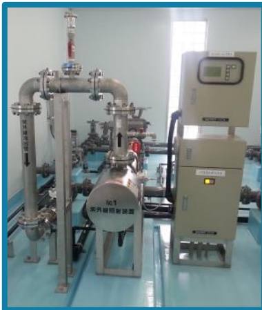
いずるじょうすいじょう 出流浄水場
