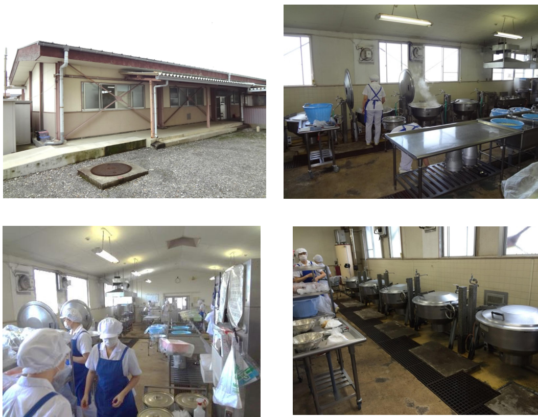
老朽化が著しい 大宮北小学校給食共同調理場 （上左：外観、上右：内部 下左：狭い調理室 下右：床が老朽化している）
