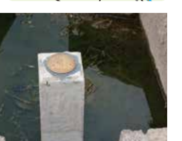
▲ 現地に設置された記念プレート
