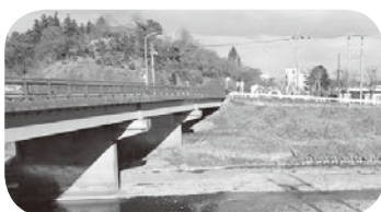
危険度合いが表示されていない永野川の上人橋
