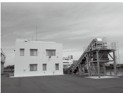
西前原排水機場
