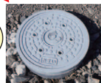
公共汚水ます
