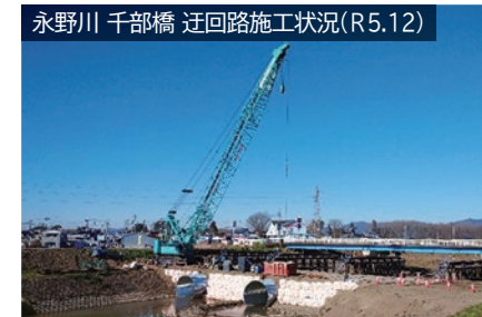
永野川 千部橋 迂回路施工状況(R5.12)
