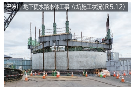
巴波川 地下掘水路本体工事 立坑施工状況(R5.12)
