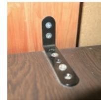
家具を直接固定するL字型金具。壁に取り付ける場合は、下地に柱がある場所へ。
