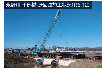
永野川 千部橋 迂回路施工状況(R5.12)
