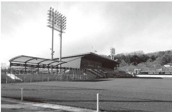
岩舟総合運動公園にあるサッカースタジアム
