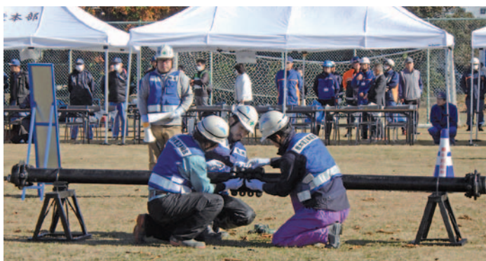
↑ 配水管の応急復旧（漏水修理）の様子
