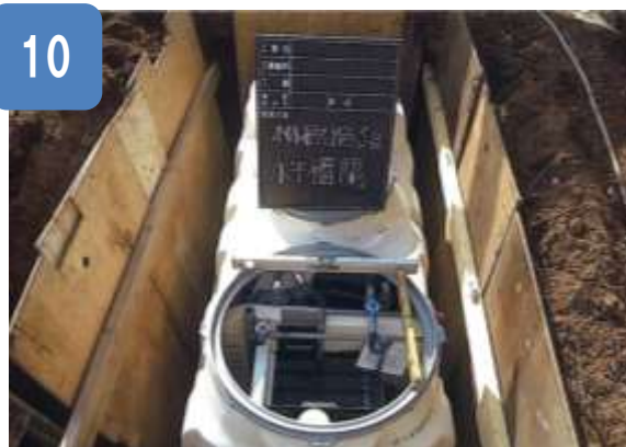
写真10 【浄化槽据付(水平確認)】
