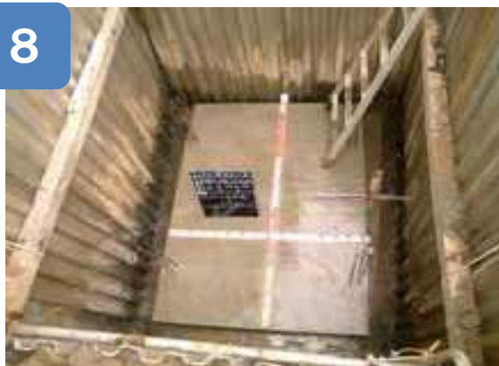
写真8 【ベースコンクリートの寸法確認】
