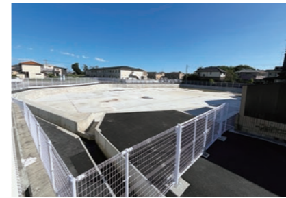
完成した調節池(平井町地内)
