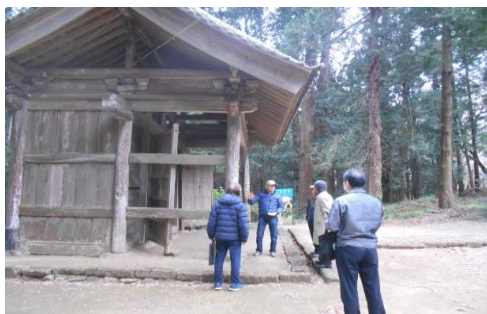
建造物調査(平成31年4月8日) 市指定文化財(建造物)大中寺山門
