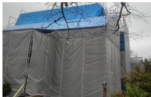
神明宮拝殿屋根等修理【修理中】
