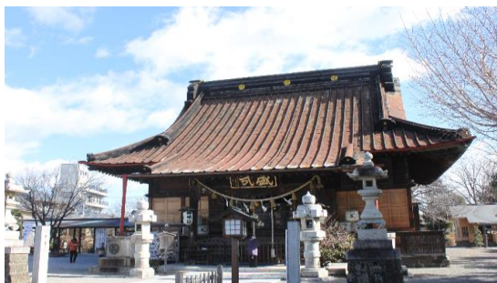
神明宮拝殿【修理前】
