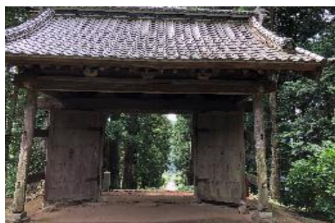
大中寺山門【修理前】
