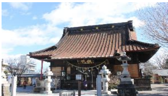
神明宮拝殿【修理前】
