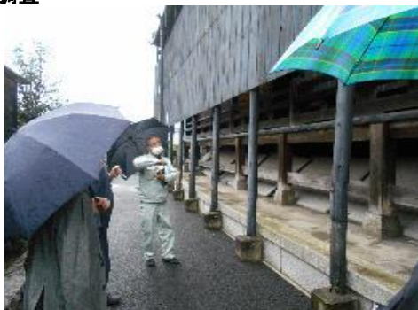
建造物調査(令和2年10月23日) 市指定文化財(建造物)近龍寺北塀
