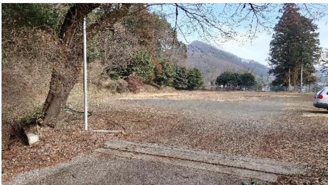
駐車場の現地確認(誘導看板無し、未舗装敷砂利)
