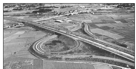
写真 昭和47年(1972)東北縦貫自動車道開通
