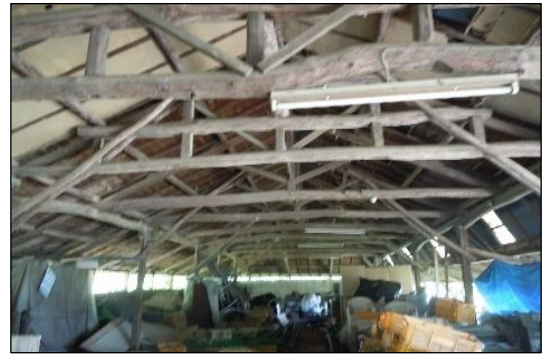
写真 にわとり小屋だった作業場の 土葺き屋根の下地
