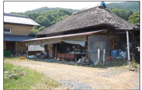
写真 大正 15 年 (1926) 建築の ぶどう農家の納屋と土蔵 (中央「茅葺屋根の納屋」・左奥「土蔵」)
