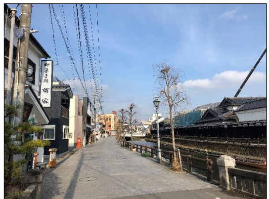
写真 巴波川沿いの電線・電柱
