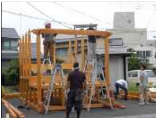
写真 仮殿の設営
