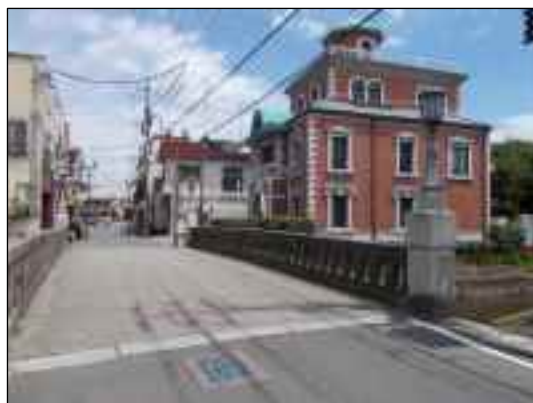
写真 ④相生橋 (昭和7年(1932))
