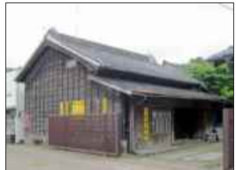
写真 岩崎肥料店木造倉庫
