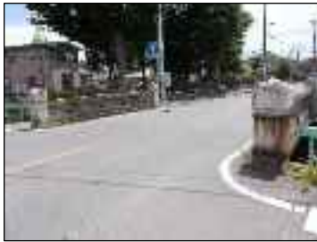
写真 ⑪富士見橋 (昭和5年(1930))
