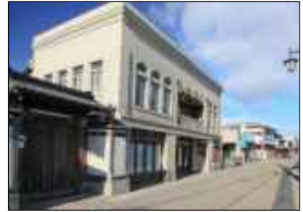
写真 c)-1 館野家店舗 [昭和7年（1932）建築《新築記念の時計》] 国登録文化財・伝統的建造物
