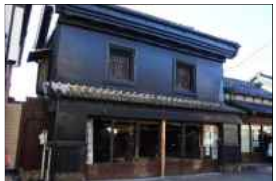
写真 a)-2 おおあき 大貫家見世蔵 [天保5年(1834)建築《墨書》] 伝統的建造物
