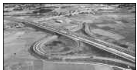
写真 昭和47年(1972)東北縦貫自動車道開通
