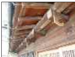
写真 出桁造
