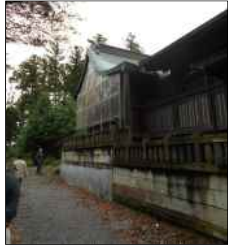
写真 近津神社本殿
