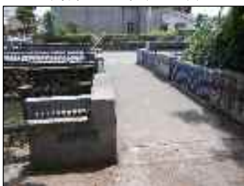
写真 ⑳栃木橋 (昭和44年(1969))
