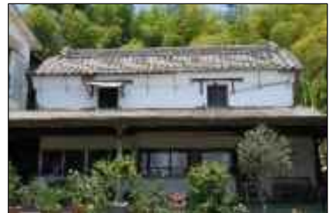
写真 下屋の下が作業場兼販売所の 大正6年（1917）建築の蔵
