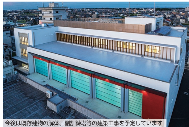
今後は既存建物の解体、副訓練塔等の建築工事を予定しています
