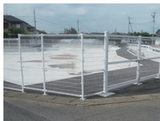
旧赤津川第2調節池（令和6年3月完成）
