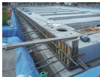
清水川地下貯留施設（令和6年5月時点）
