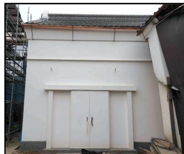
〔修理済の建造物〕
