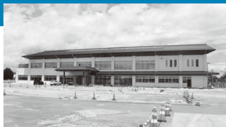
新築工事が進む都賀総合支所複合施設
