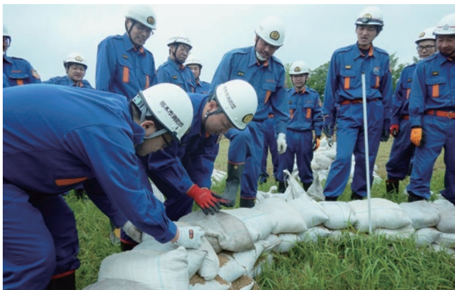
土のうの積み上げ方を実践で学びます
