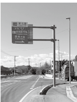
令和 5 年 9 月に開通した 都賀西方スマートインター
