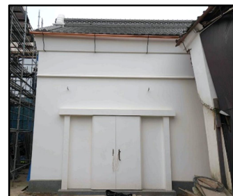
〔修理済の建造物〕
