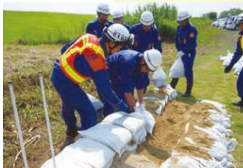
▲ 土のうと鋼杭を使用した積土のう
