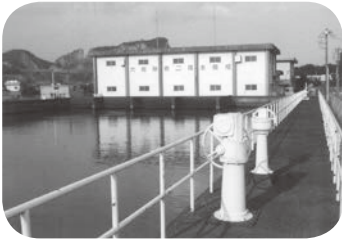
大岩藤第二揚水機場
