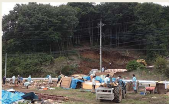
地すべりによる作業所の倒壊(西方町真名子)
