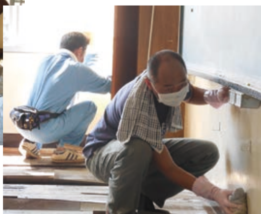
部屋小学校における復旧作業
