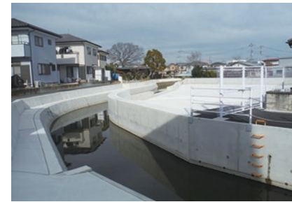
旧赤津川第1調節池(令和6年11月完成)
